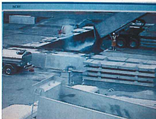
場内埋め立て作業
