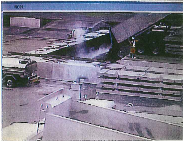
場内埋め立て作業
